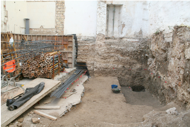
C/ Adarve, 33 [35]. Panorámica general de las obras con localización de estratigrafía arqueológica de la Prehistoria reciente, al fondo a la derecha, como trabajo previo a su protección para su no afección por el proyecto de nueva planta.
