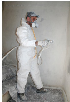
Castillo. Encalo del interior de las escaleras de caracol de la torre del homenaje.
