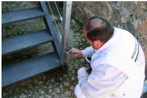
Castillo. Trabajos de mantenimiento en las estructuras metálicas de conexión entre sectores.
