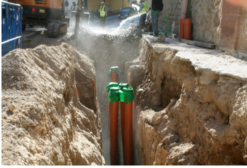
C/ San Pedro Alcántara. Reapertura de zanja para infraestructuras. Panorámica general de las obras.
