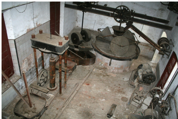
Molino de San Antonio, en el paseo de Colombia. Sala de prensa- do. Estado actual.
